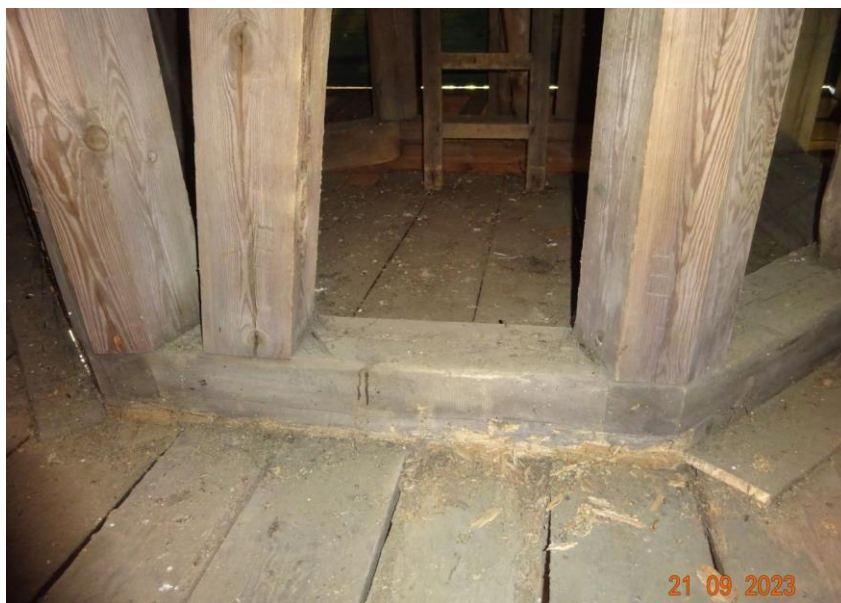
Fot.14 Podstawa dzwonów porażona przez owady -szkodniki drewna
