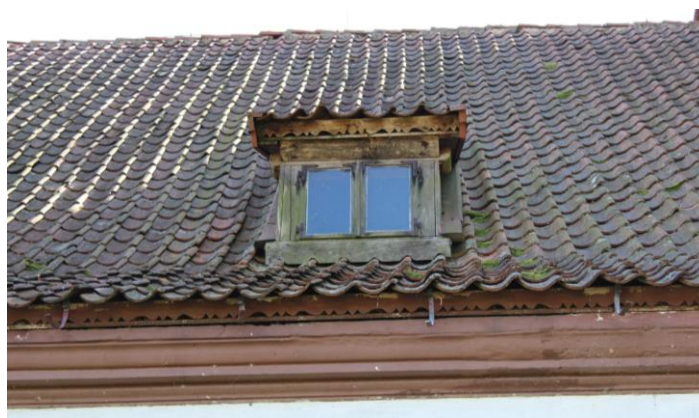
Fot.11 Zapadnięta połać dachowa po stronie północnej ,Brak rynny. Uszkodzone pojedyncze dachówki .Uszkodzona rama okna
