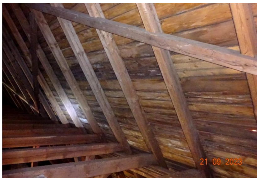
Fot.8 Więźba dachowa po stronie północnej dachu. Widoczne różowe i białe naloty grzybów.Pobrano PRÓBKĘ NR 2
