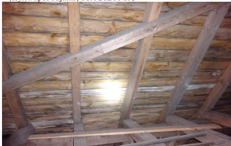
Fot.10 Miejsce lokalnych zacieków .Z deskowania pobrano PRÓBKĘ NR 1 .Deskowanie do wymiany
