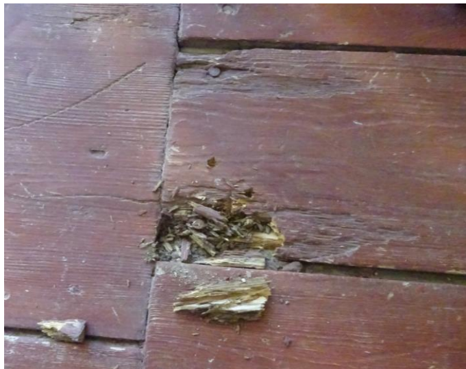
Fot.19 Miejscowe uszkodzenie podłogi drewnianej empory
