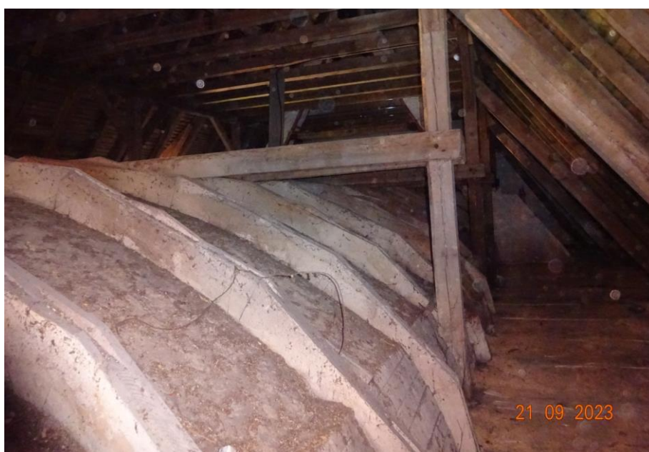
Fot.6 Krążyny stropu kolebkowego , punktowo na krawędziach
