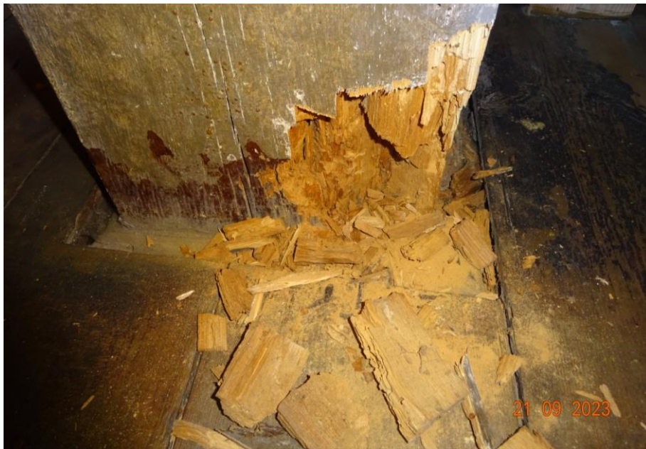
Fot.7 Podstawa słupa podpierającego empore uszkodzona przez owady i grzyb domowy (Pobrano PRÓBKĘ NR 3)
