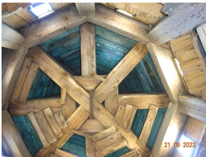
Fot.13 Kopuła wieży dzwonnej z widocznym zielonym impregnatem na deskowaniu połaci dachowej
