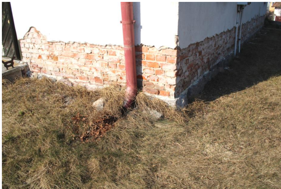
Fot.21 Zbyt wysoka rzędna terenu , dochodząca do poziomu izolacji przeciwwilgociowej ( poziomej z papy)
