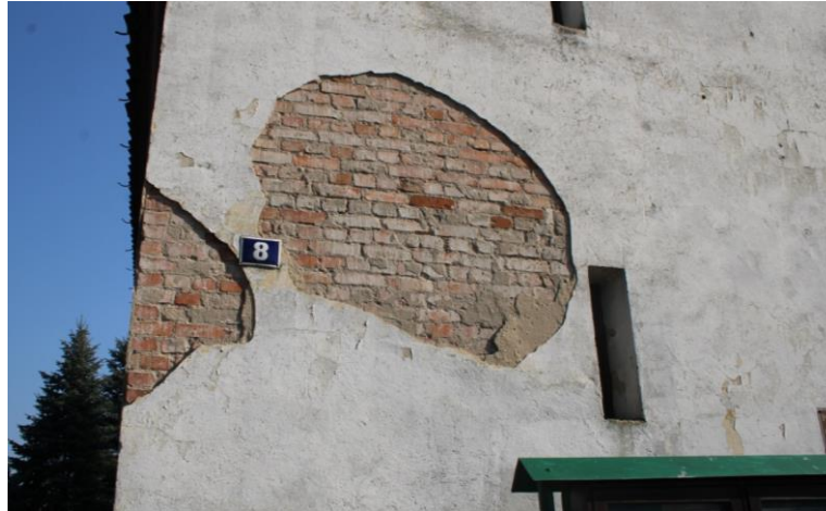
Fot.16 Elewacja frontowa kościoła. Miejscowe odpadanie tynku
