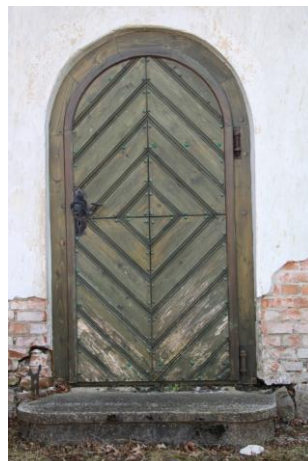
Fot.12 Uszkodzone malowanie drzwi zewnętrznych
