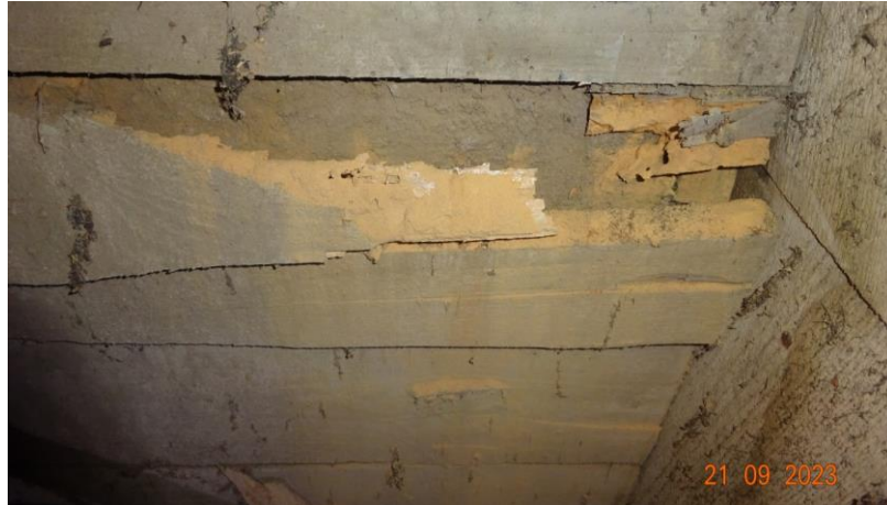
Fot.9 Deskowanie połaci uszkodzone przez Spuszcza pospolitego ( Hylotrupes bajulus ) PRÓBKA NR 3
