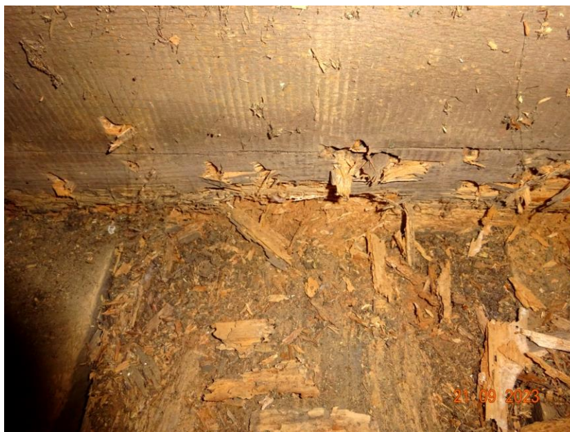
Fot.22 Miejscowe uszkodzenie belki podstawy dzwonów przez Spuszcza pospolitego ( Hylotrupes bajulus )
