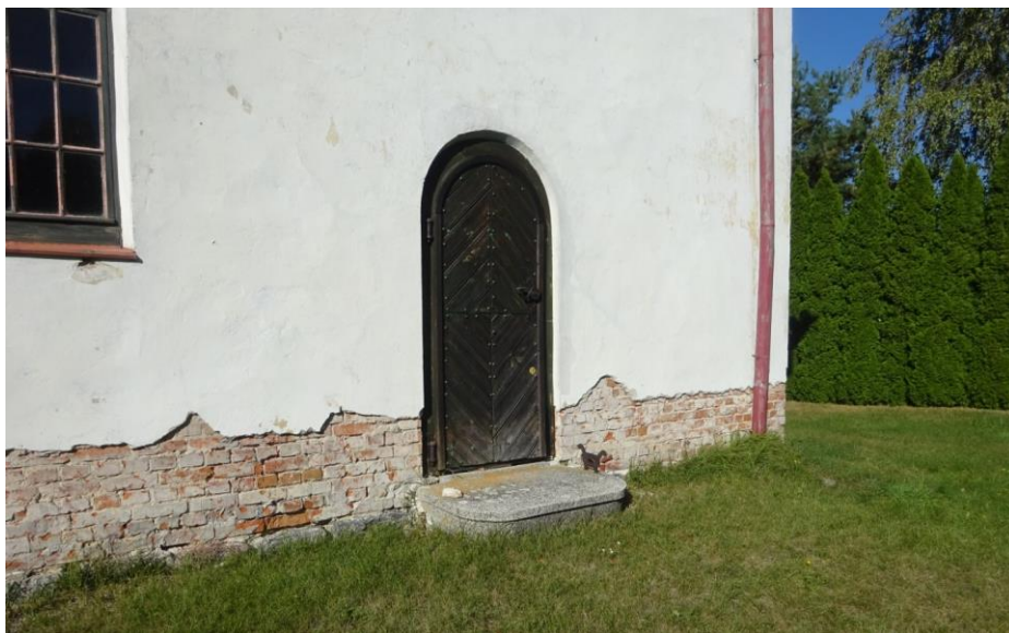
Fot.4 Poziom terenu na wysokości izolacji poziomej przeciwwilgociowej
