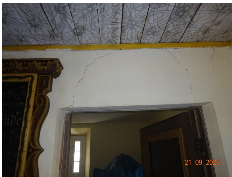
Fot.5 Ściana wewnętrzna z uszkodzoną strefą nadprożową muru. Wymaga pilnej naprawy
