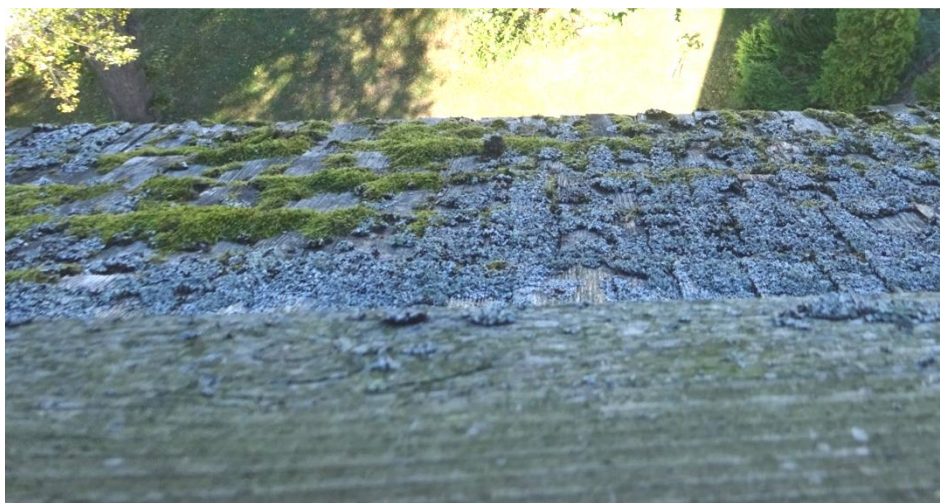
Fot.15 Rozwój mchów, porostów i glonów na gontach pokrycia więzy
