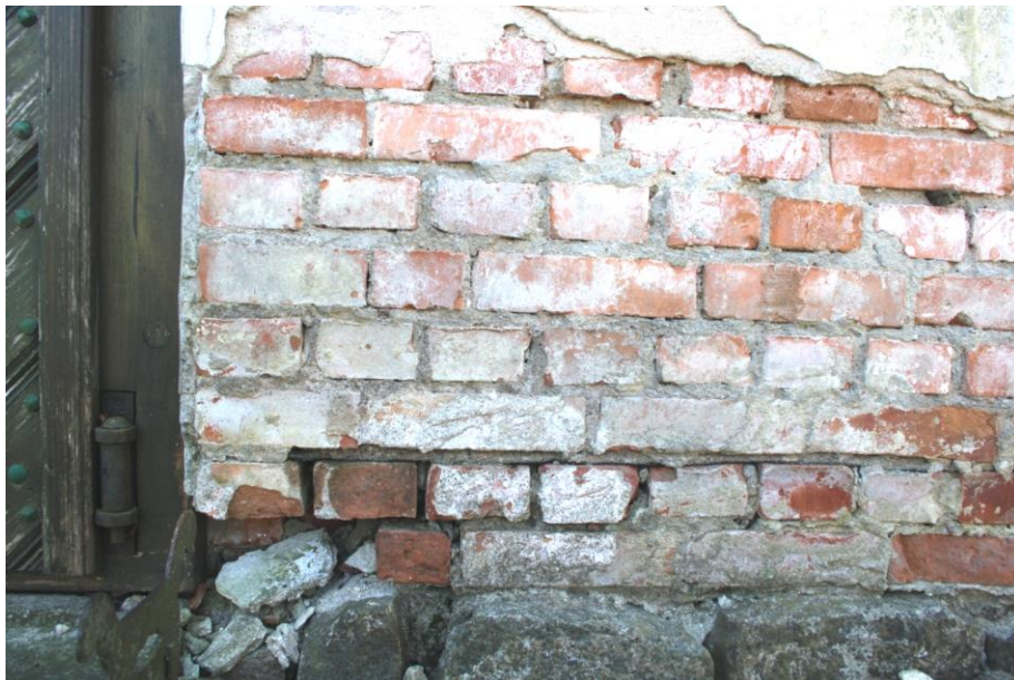
Fot.3 Strefa cokolowa - brak wiązania bloków kamiennych i cegły. Po dwóch warstwach cegły , jest izolacja pozioma z papy. Pobrano PRÓBKĘ NR 6
