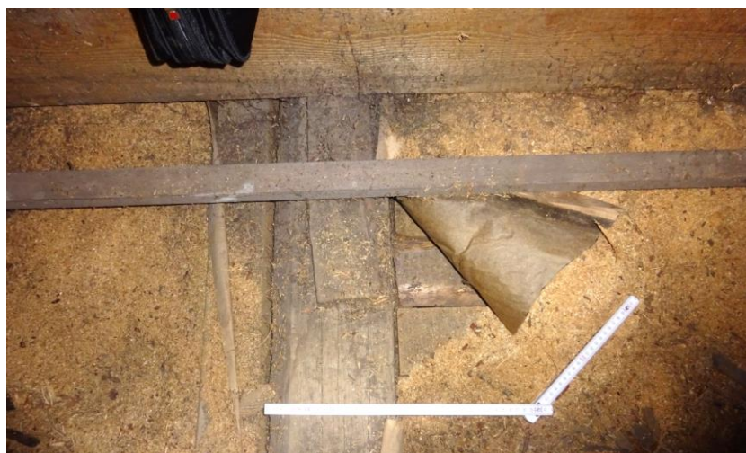
Fot. 20 Pergaminowa izolacja pod polepą w stropie nad parterem
