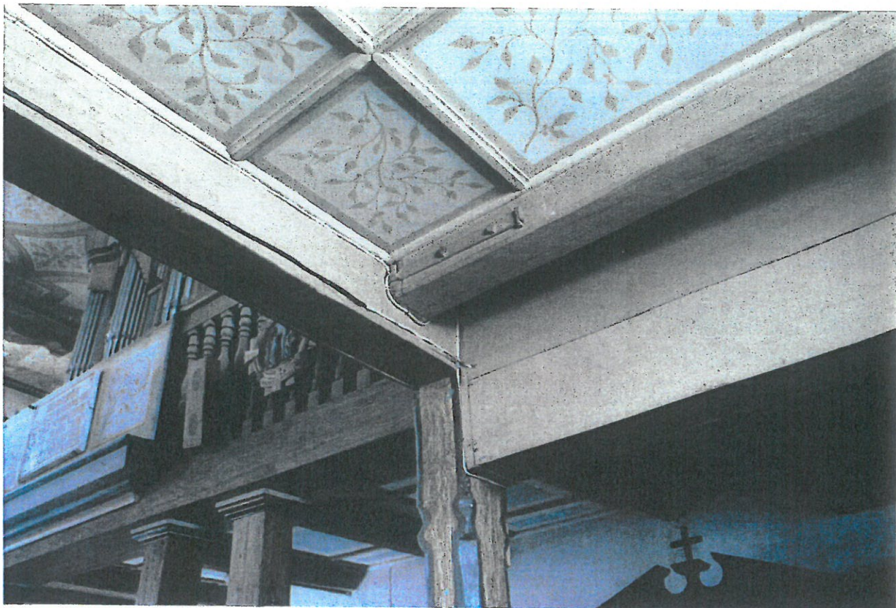
ZDJ. 17, 18 ORZYSZ, KOŚCIÓŁ P.W. MATKI BOŻEJ SZKAPLERZNEJ. OSZALOWANA NOWYMI DESKAMI PODPORA EMPORY ZAATAKOWANA PRZEZ KOŁATKA PONIŻEJ – ZBLIŻENIE
