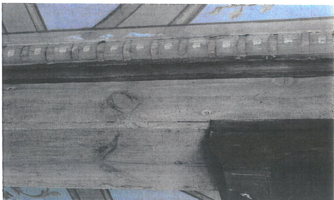
ZDJ. 21, 22 ORZYSZ, KOŚCIÓŁ P.W. MATKI BOŻEJ SZKAPLERZNEJ.. BELKA STROPOWA EMPORY OSZALOWANA NOWYMI DESKAMI – WIDOCZNE ŚLADY ŻEROWANIA KOŁATKA
