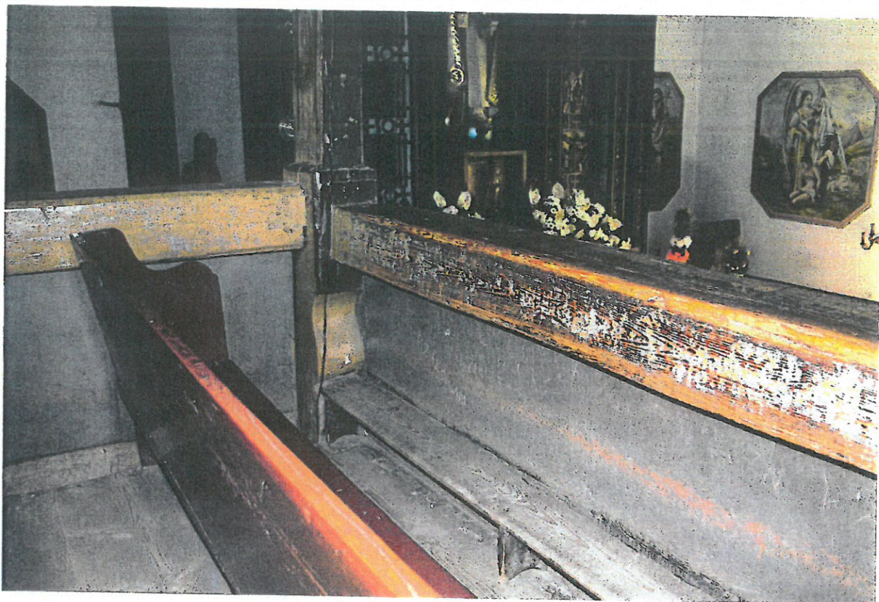
ZDJ. 7 ORZYSZ, KOŚCIÓŁ P.W. MATKI BOŻEJ SZKAPLERZNEJ. WNĘTRZE. SŁUP Z POZIOMU EMPORY – WIDOCZNE ZMNIĘSZCZENIE OBWODU SŁUPA POWYŻEJ BALUSTRADY
