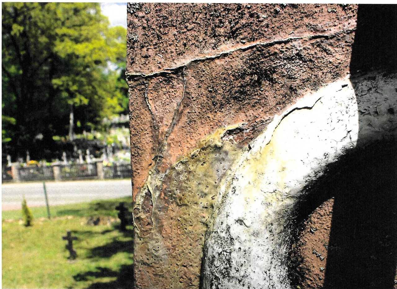
ZDJ.9, 10. ORZYSZ. POMNIK POŚWIĘCONY ŻOŁNIERZOM ALIANKIM Z 1914 NA CMENTARZU WOJENNYM 1914 – 1919. ZDJĘCIE 2022. PĘKNIĘCIA I ROZWARSTWIENIA WARSTWY POWIERZCHNIOWEJ, WIDOCZNE BIAŁE NACIEKI WAPNIOWE W WYNIKU KOROZJI ŁUGUJĄCEJ BETONU
