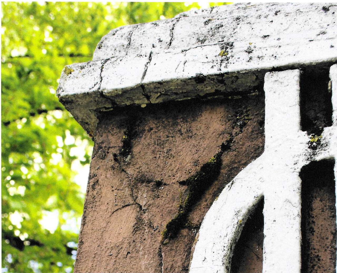
ZDJ.5, 6. ORZYSZ. POMNIK POŚWIĘCONY ŻOŁNIERZOM ALIANCKIM Z 1914 NA CMENTARZU WOJENNYM 1914 – 1919. ZDJĘCIE 2022. PĘKNIĘCIA WARSTWY POWIERZCHNIOWEJ, GZYMSU I DETALU
