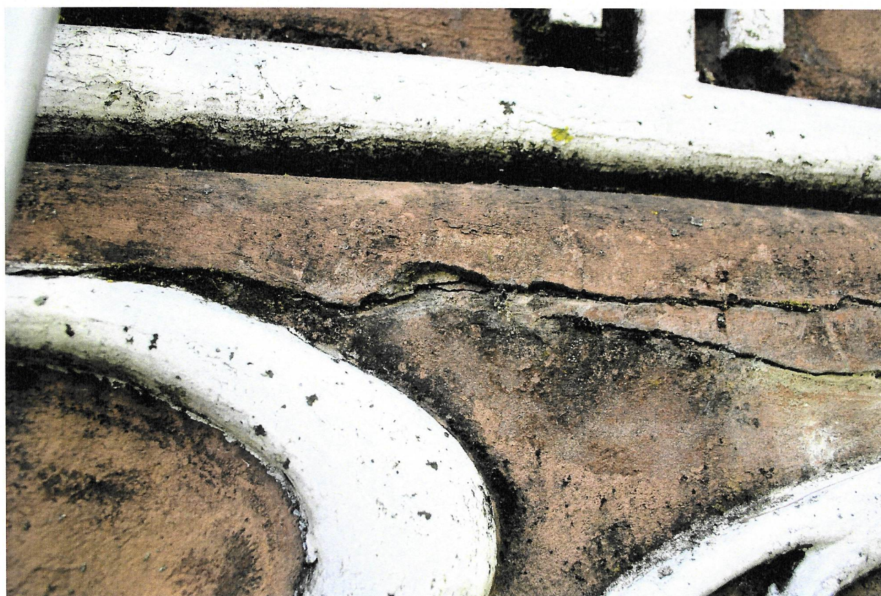
ZDJ.7, 8. ORZYSZ. POMNIK POŚWIĘCONY ŻOŁNIERZOM ALIANKIM Z 1914 NA CMENTARZU WOJENNYM 1914 – 1919. ZDJĘCIE 2022. PĘKNIĘCIA I ROZWARSTWIENIA WARSTWY POWIERZCHNIOWEJ,
