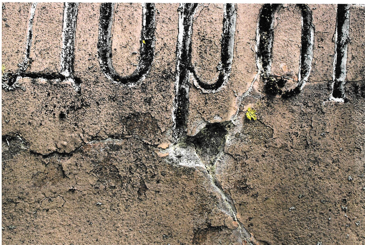
ZDJ.7, 8. ORZYSZ. POMNIK POŚWIĘCONY ŻOŁNIERZOM ALIANKIM Z 1914 NA CMENTARZU WOJENNYM 1914 – 1919. ZDJĘCIE 2022. PĘKNIĘCIA I ROZWARSTWIENIA WARSTWY POWIERZCHNIOWEJ,
