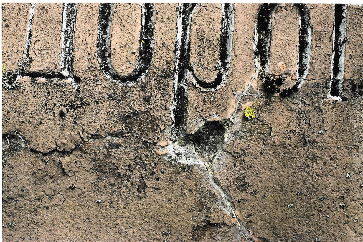
ZDJ.9, 10. ORZYSZ. POMNIK POŚWIĘCONY ŻOŁNIERZOM ALIANKIM Z 1914 NA CMENTARZU WOJENNYM 1914 – 1919. ZDJĘCIE 2022. PĘKNIĘCIA I ROZWARSTWIENIA WARSTWY POWIERZCHNIOWEJ, WIDOCZNE BIAŁE NACIEKI WAPNIOWE W WYNIKU KOROZJI ŁUGUJĄCEJ BETONU
