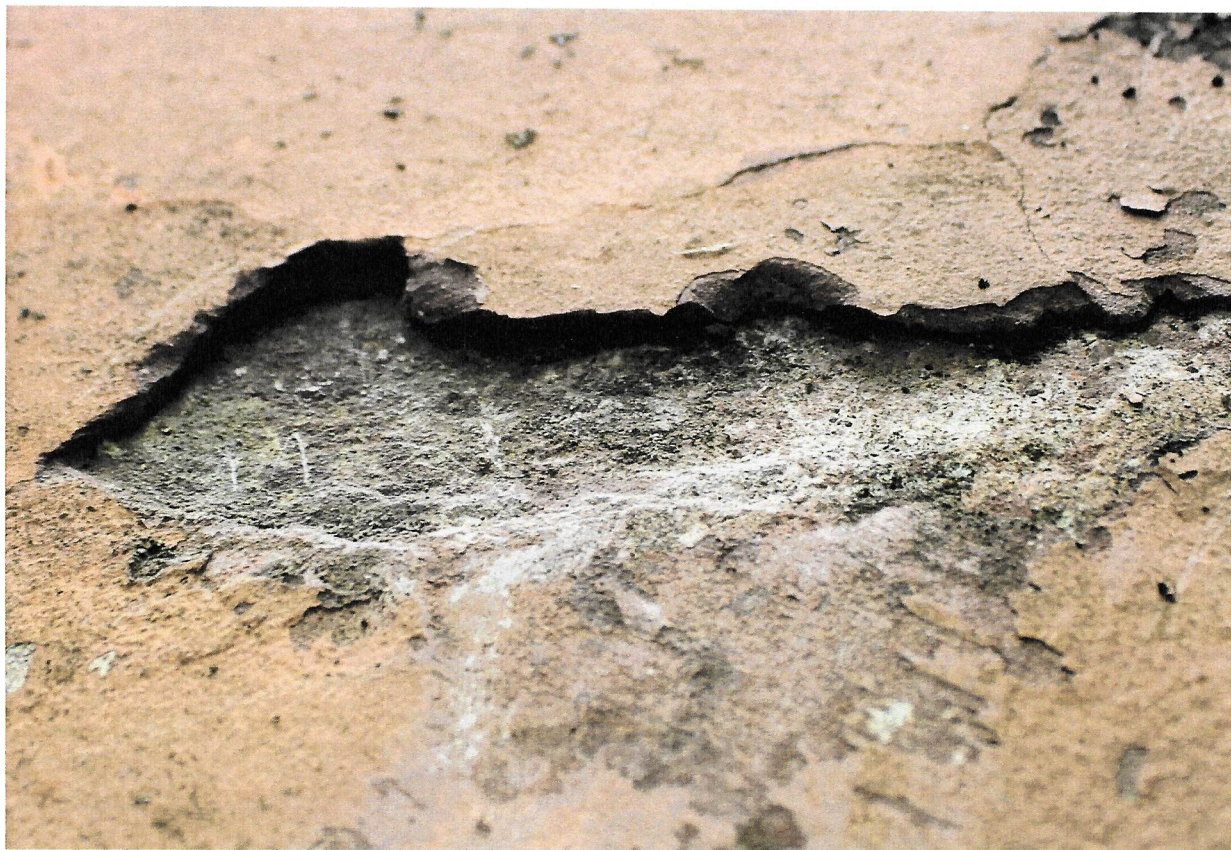
ZDJ.16. ORZYSZ. POMNIK POŚWIĘCONY ŻOŁNIERZOM ALIANCKIM Z 1914 NA CMENTARZU WOJENNYM 1914 – 1919. ZDJĘCIE 2023. W PRZEŁOMIE WIDOCZNA WARSTWA POWIERZCHNIOWA BARWIONA W MASIE
