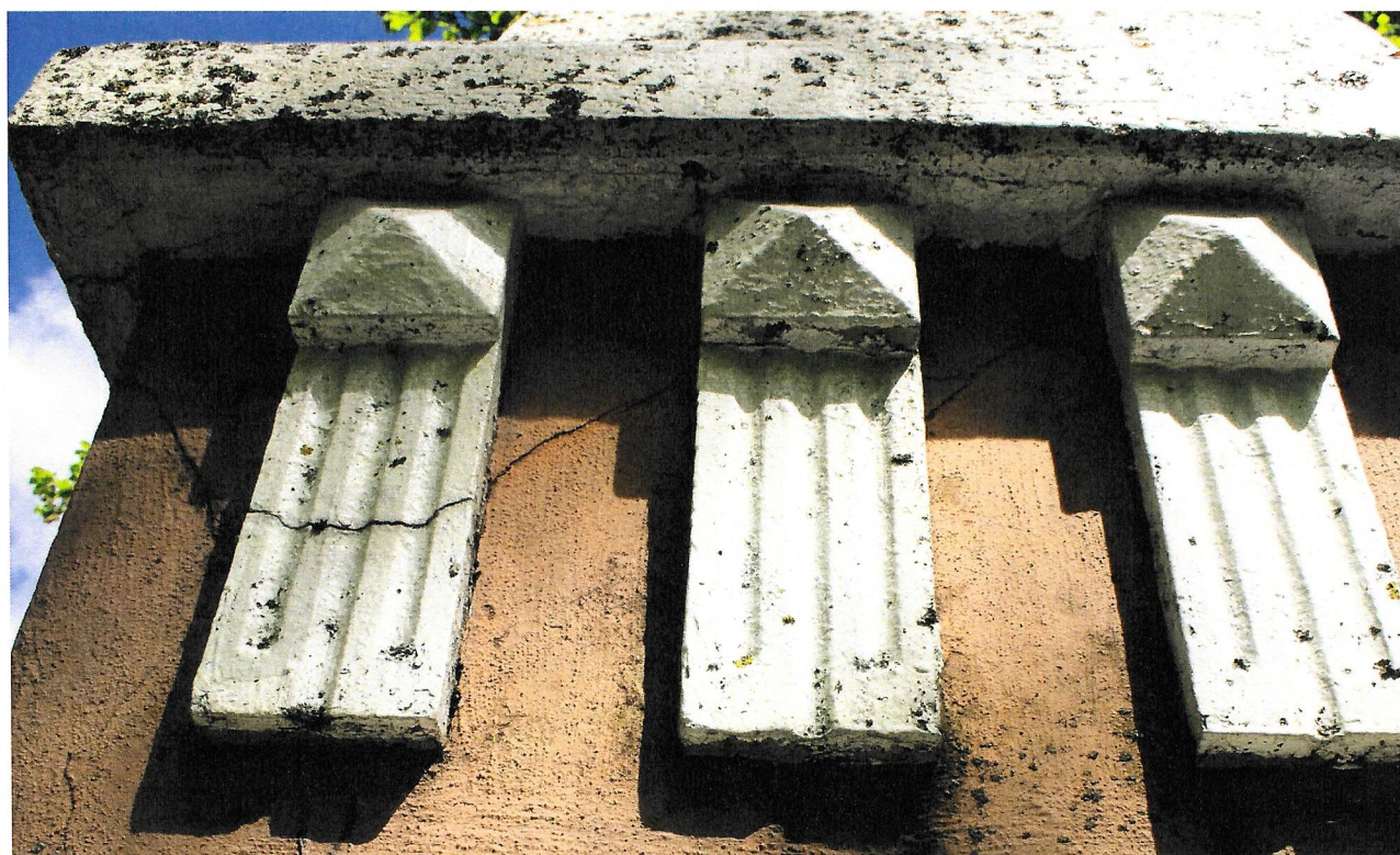
ZDJ.5, 6. ORZYSZ. POMNIK POŚWIĘCONY ŻOŁNIERZOM ALIANCKIM Z 1914 NA CMENTARZU WOJENNYM 1914 – 1919. ZDJĘCIE 2022. PĘKNIĘCIA WARSTWY POWIERZCHNIOWEJ, GZYMSU I DETALU
