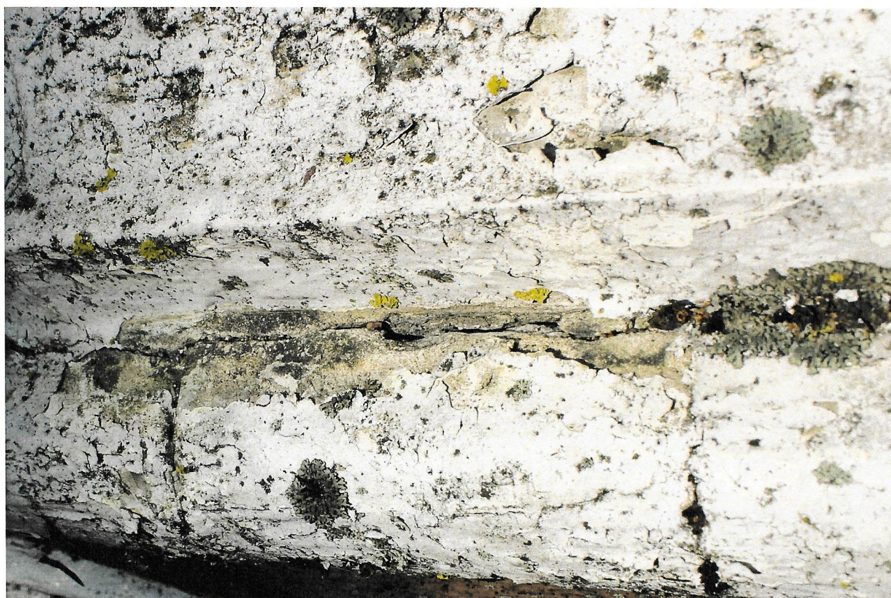
ZDJ.17. ORZYSZ. POMNIK POŚWIĘCONY ŻOŁNIERZOM ALIANCKIM Z 1914 NA CMENTARZU WOJENNYM 1914 – 1919. ZDJĘCIE 2023. ODSPOJONY WAŁEK GZYMSY I POD DWIEMA WARSTWAMI BIAŁEJ FARBY WIDOCZNA JASNO SZARA WARSTWA GŁADZONEJ ZAPRAWY CEMENTOWEJ
