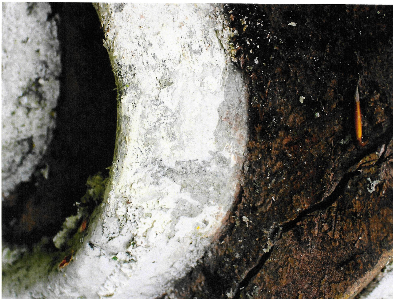
ZDJ.18. ORZYSZ. POMNIK POŚWIĘCONY ŻOŁNIERZOM ALIANKIM Z 1914 NA CMENTARZU WOJENNYM 1914 – 1919. ZDJĘCIE 2023. FRAGMENT DETALU - POD DWIEMA WARSTWAMI BIAŁEJ FARBY WIDOCZNA JASNO SZARA WARSTWA GŁADZONEJ ZAPRAWY CEMENTOWEJ
